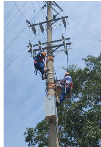
Ilustración 2. Instalación de reconector Puente Balin – CCR1 SE Cmar.
