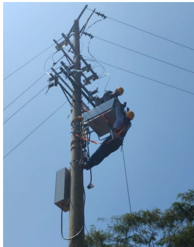
Ilustración 2. Instalación de reconector Puente Balin – CCR1 SE Cmar.
