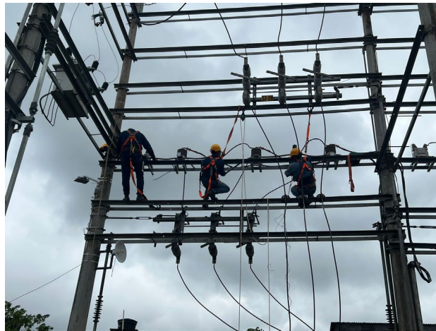
Ilustración 5. Instalación de PQ's y medidores CT's y PT's
