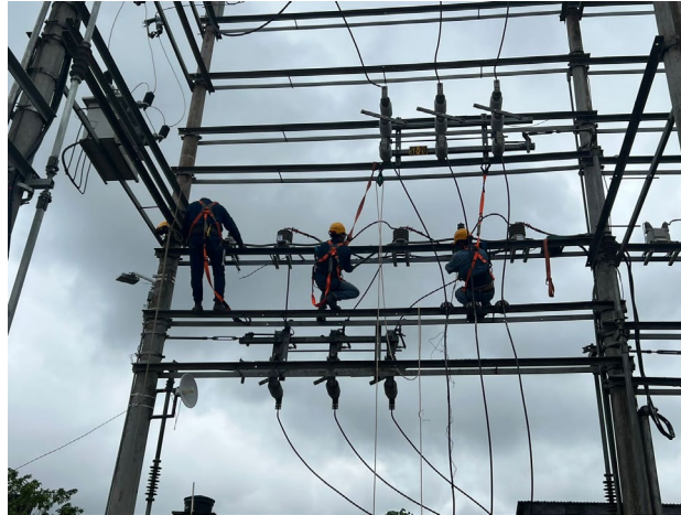
Ilustración 9. Instalación de PQ's y medidores CT's y PT's
