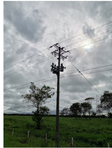
Ilustración 5. Instalación de reconector Viso – CC SJG.
