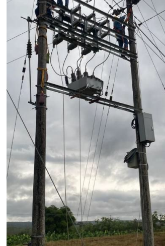
Ilustración 8. Reconector de cabecera línea SE SJG – SE Retorno.
