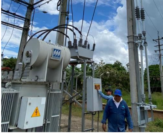
Ilustración 7. Reconector de entrada SE Capricho (34.5 kV).
