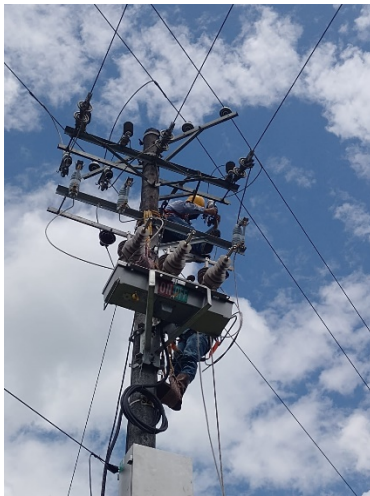
Ilustración 4. Instalación de reconector Joselin – C2 SJG.
