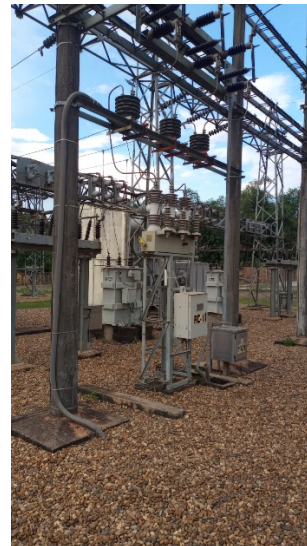
Ilustración 3. Reconector de reemplazo Dog house Nivel de tensión 3 (TP1)
