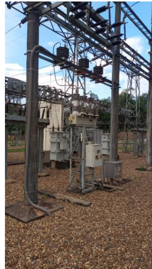
Ilustración 10. Reconector de reemplazo Dog house Nivel de tensión 3 (TP1)
