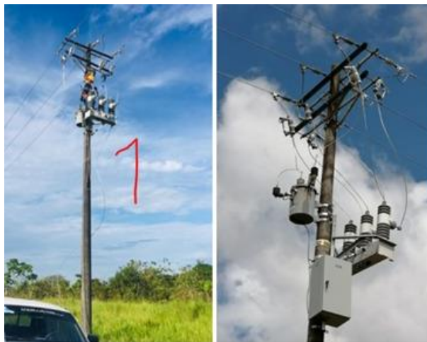
Ilustración 8. Reconector instalado en el sector de barrancón.
