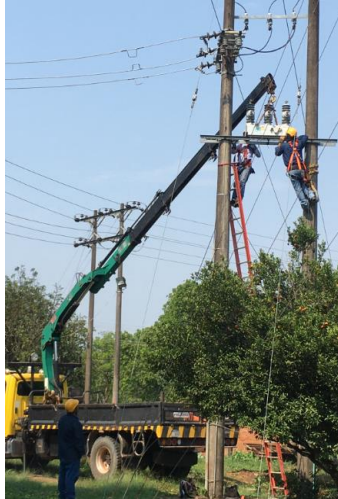
Ilustración 12. Independización de circuitos C4-CC
