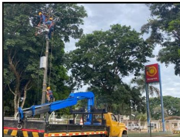
Ilustración 11. Instalación del reconductor sector Terpel.
